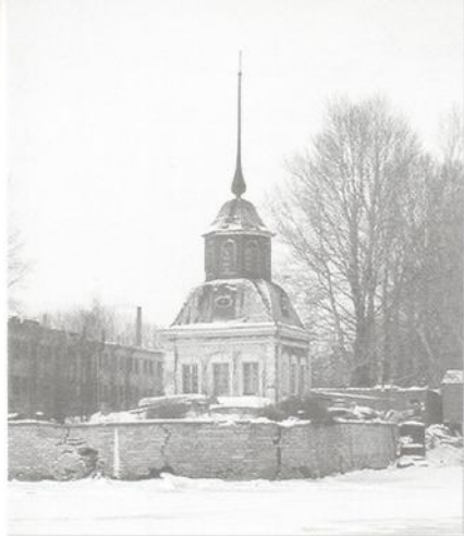
Кроншпиц на входе в Галерную гавань
