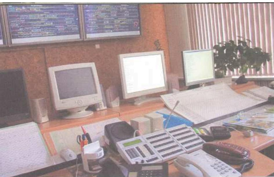
Мониторы на стене в реальном времени отражают перемещение поездов на линии, мониторы на пульте фиксируют соответствие графику или отклонение от него.
