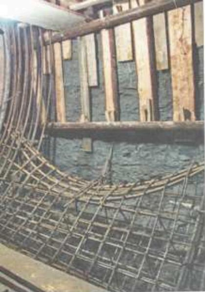
Эту арматуру зальют бетоном и в зелёной кембрийской глине пробуют ход к параллельному тоннелю.
