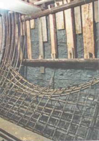
Эту арматуру залят бетоном и в зелёной кембрийской глине пробьют ход к параллельному тоннелю.
