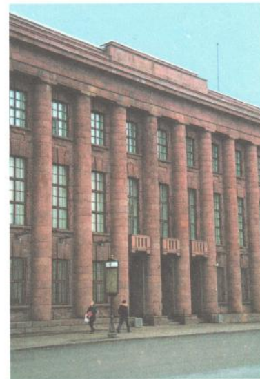
Здание Германского посольства на Исаакиевской площади, д. 11/41
