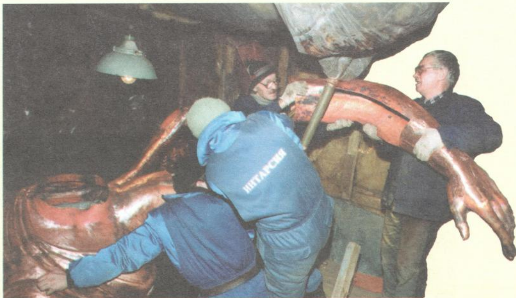
Сборка фигуры Славы. Внизу виден латунный каркас
